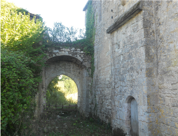
Le porche avant la récente restauration
